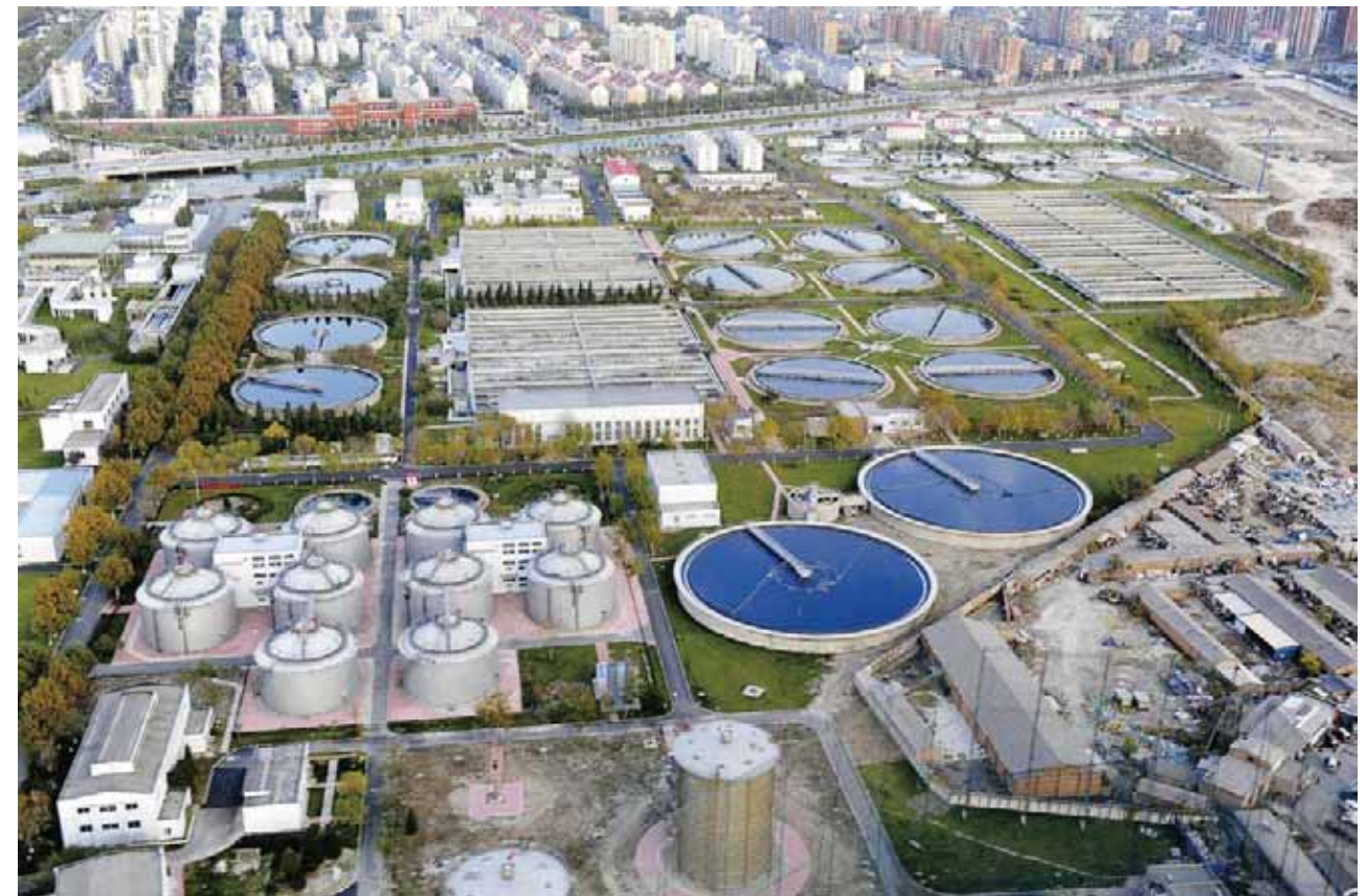
天津 纪庄子污水处理厂 图片来源：《中国城镇供排水蓬勃发展的60年》
