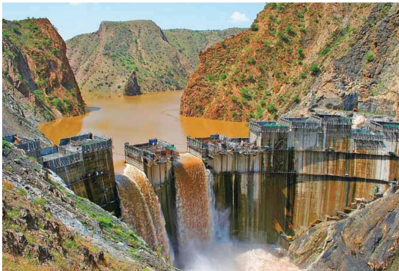
▲ Le barrage-voûte sur le Tekezé (Tigray, Nord de l'Éthiopie), affluent du Nil qui coule à travers les canyons les plus profonds du monde. Ses quatre turbines produisent en tout 300 MW de courant. ©Paul Snook.
