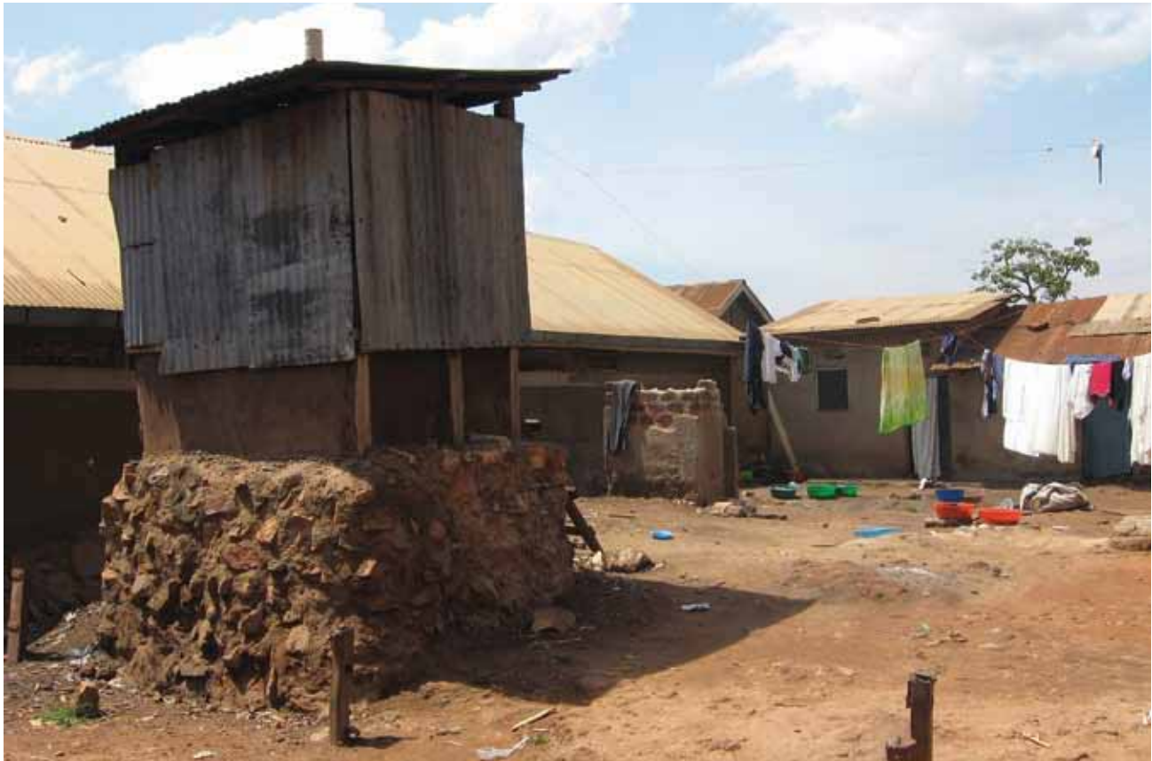
▲ Ce type de latrine à fosse est très répandu dans les bidonvilles de Kampala (Ouganda). La dalle est surélevée pour la protéger des inondations chroniques. ©SuSanA Secretariat. Licence générique Creative Commons Attribution 2.0.
