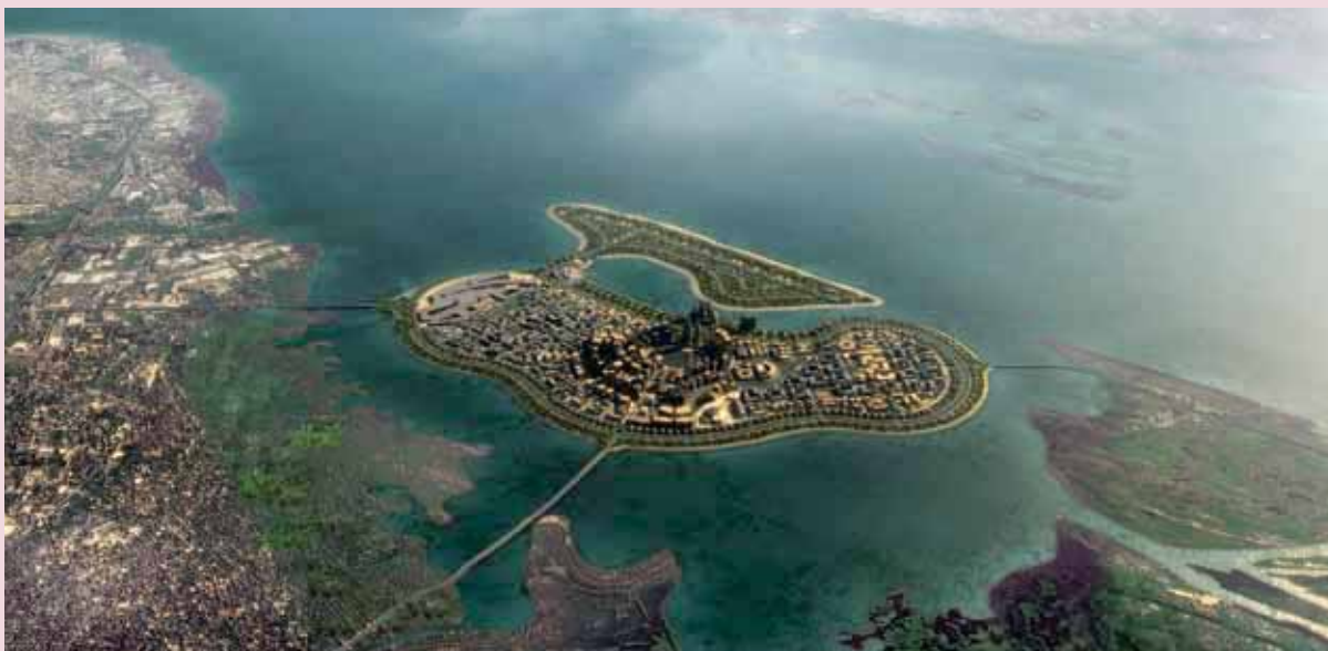
▲ "L'Avenir de Kinshasa". Les travaux sont bien engagés pour remettre en valeur les terrains devant accueillir La Cité du Fleuve. ©La Cité du Fleuve
