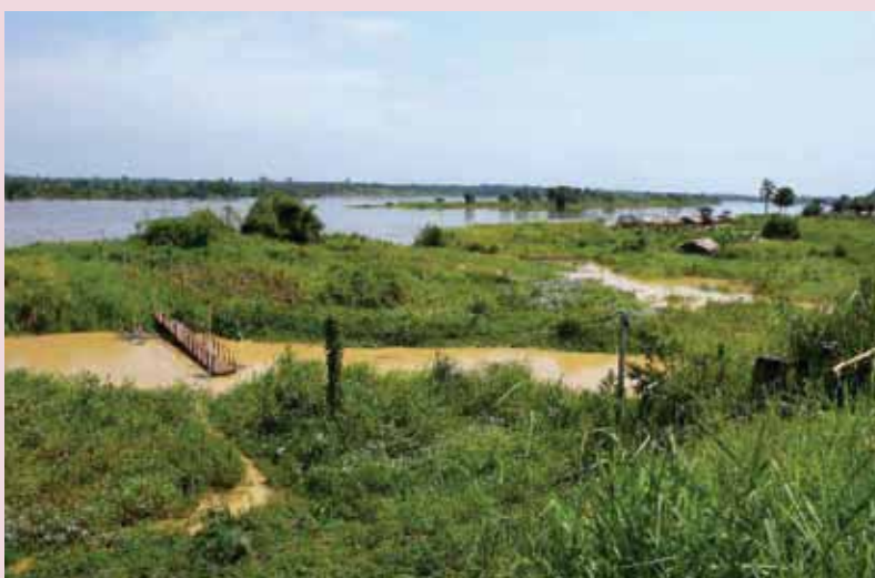
▲ Sa dégradation menace le fonctionnement du captage qui alimente la distribution d'eau à Kindu (RDC). ©UNEP
