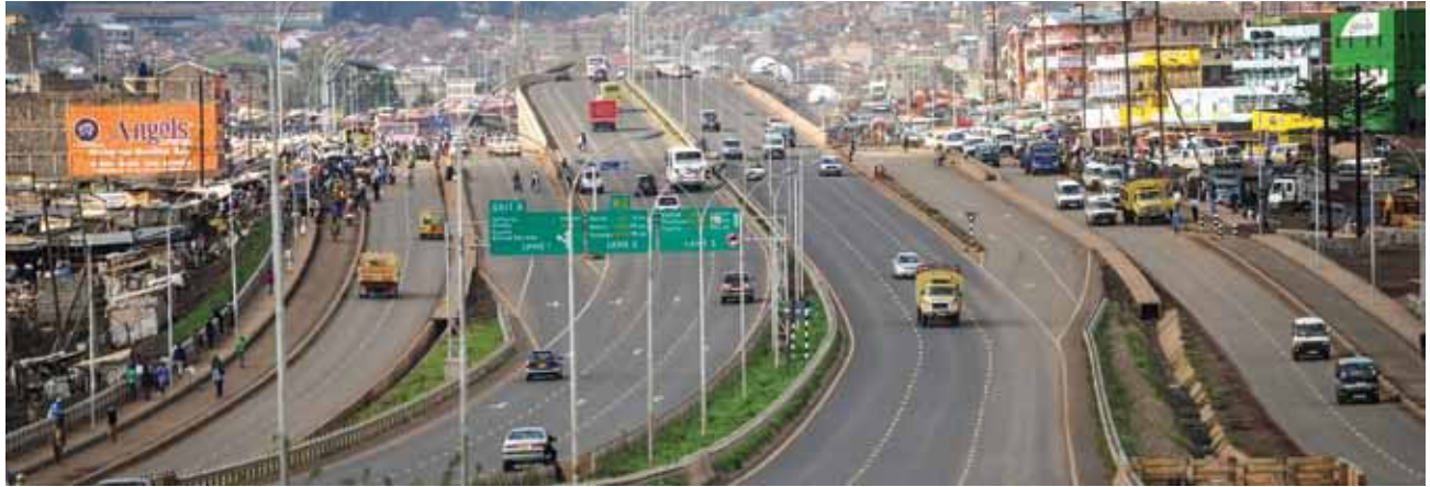
▲ La nouvelle autoroute de Thika (Kenya). Le bâtiment, les travaux publics et les télécommunications devraient rester les piliers de la croissance du pays. ©Fountain Monthly -www.fountainnews.co.ke
