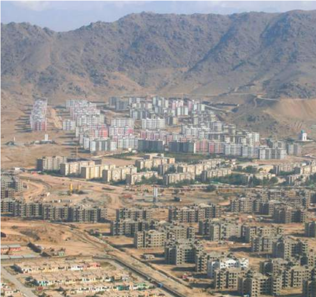
آپارتمان‌های در حال ساخت، کابل
