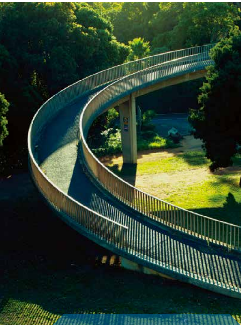
南非开普敦 (Cape Town) 附近的一处步行桥(部分的栏杆被偷走当作废品)。 A pedestrian bridge (part of the railing stolen for scrap) near Cape Town, South Africa. 2012 Rodger Shagam/fotoLIBRA.com 版权所有：2012 Rodger Shagam/fotoLIBRA.com
