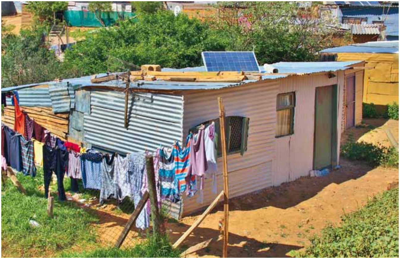
Les énergies renouvelables ont l'avantage d'offrir un accès hors réseau qui favorise une meilleure inclusion sociale
