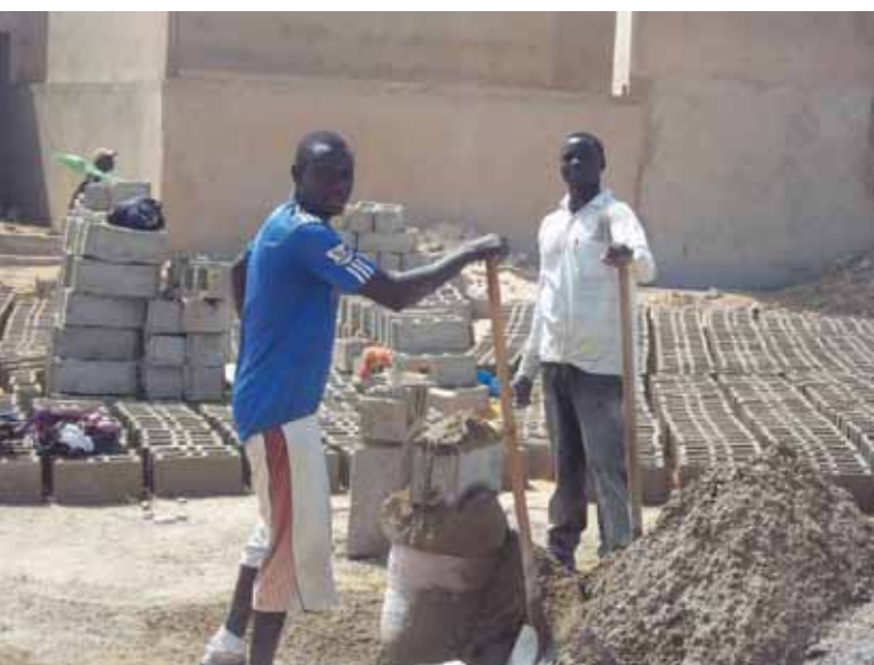
Photo 37. Mouleurs de parpaings à la VDN, Dakar Source : IAGU 2012
