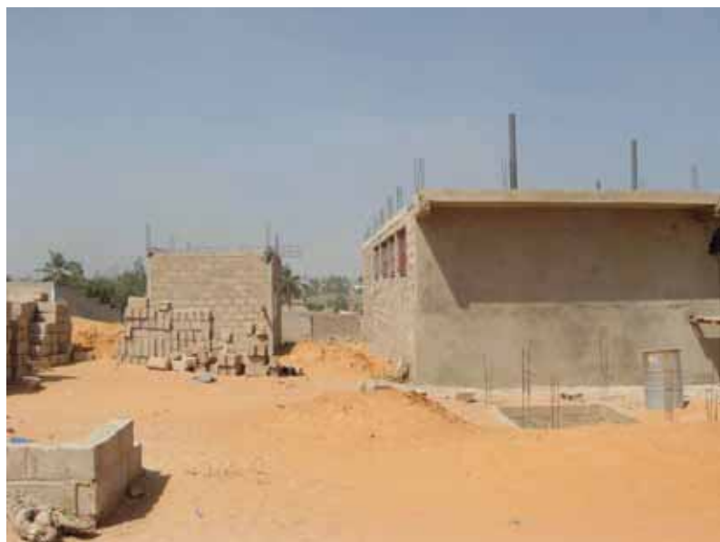
Photo 35. Parpaings (ou agglomérés) et chantier de construction dans la banlieue de Dakar
