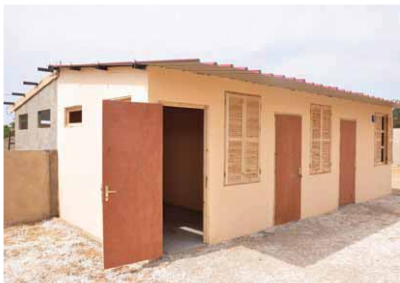
Photo 11. Maison construite dans le cadre du projet de re-logement de populations vulnérables aux risques naturels à Saint-Louis
