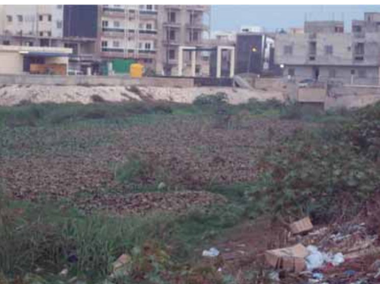
Photo 10. Bassin de rétention, zone de captage, Dakar Source : IAGU 2012
