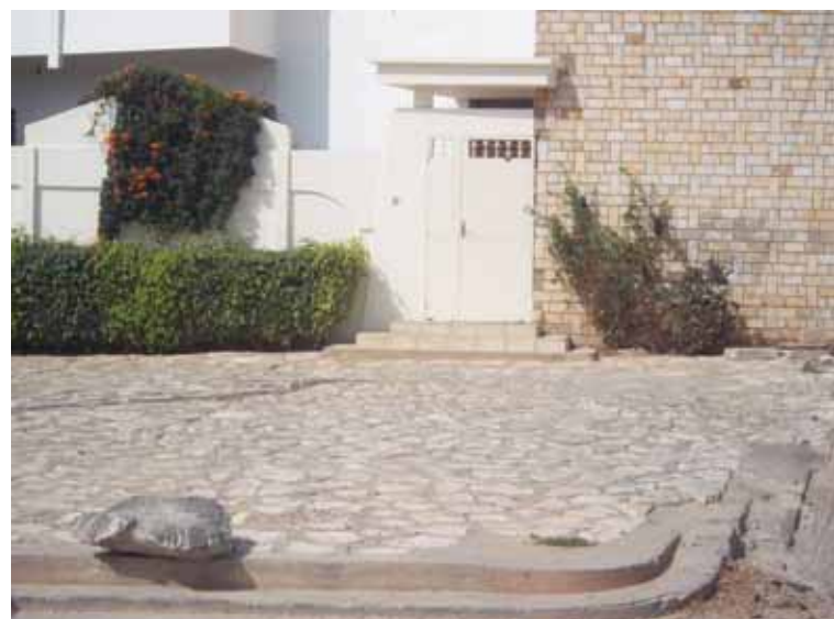
Photo 34. Pavés et revêtement mural en pierres de Rufisque dans les anciens locaux de IAGU à Liberté 6, Dakar Source : IAGU 2012
