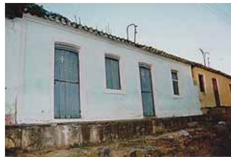
Fotografia 2.29 – Tipologia de edificações encontradas no Centro Histórico leste
