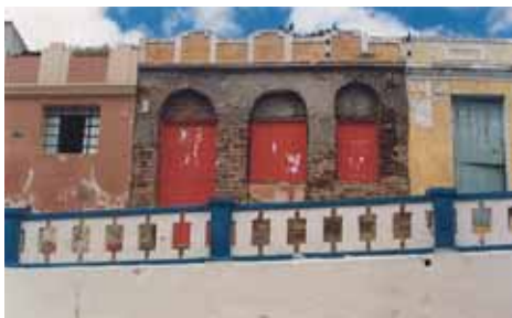
Fotografia 3.18 – Ruína reconstruída, Piranhas Centro Histórico
