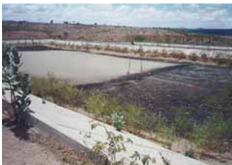
Fotografia 2.39 – Uma das três lagoas de estabilização do bairro de Nossa Senhora da Saúde
