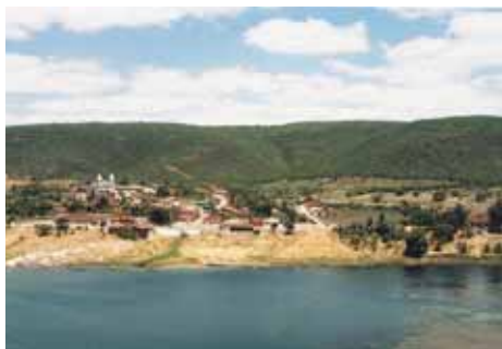
Fotografia 2.32 – Vista aérea de Entremontes com destaque para as torres da Igreja Matriz
