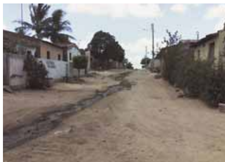
Fotografia 2.6 – Vias não pavimentadas, bairro de Nossa Senhora da Saúde
