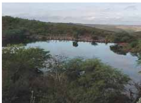
Fotografia 2.34 – Lagoa de estabilização secundária
