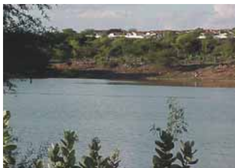
Fotografia 2.33 – Lagoa de estabilização primária
