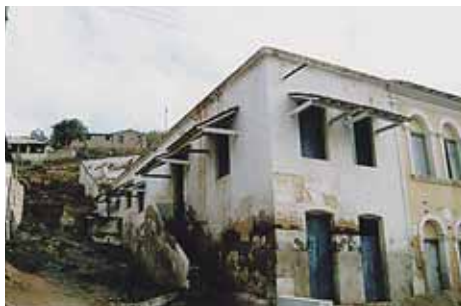
Fotografia 3.23 – Antigo vazio utilizado como caminho, hoje incorporado à edificação vizinha como garagem
