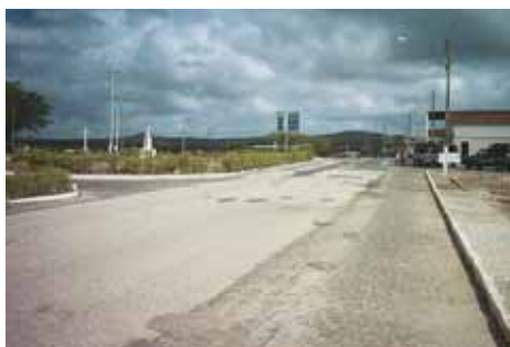
Fotografia 2.1 – Vista da rodovia Altemar Dutra: limite do bairro de Nossa Senhora da Saúde com o bairro Xingó e elo de ligação com o Centro Histórico
