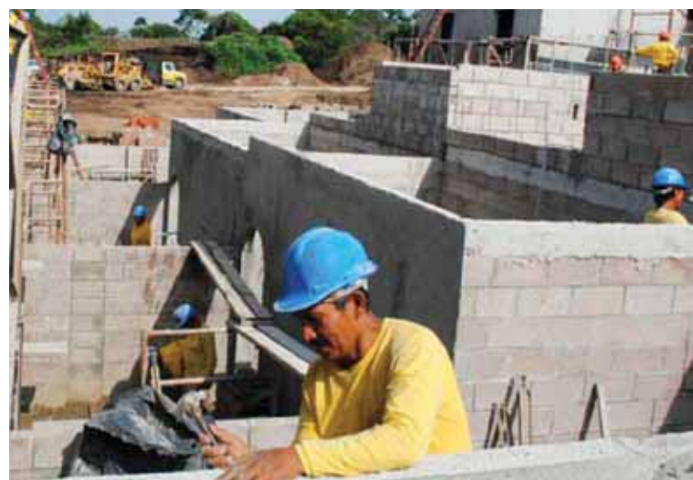
Foto 1. Construcción de vivienda con bloque de concreto (FUNDASAL).
