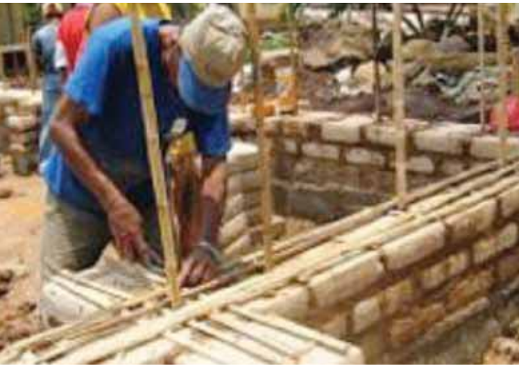
Foto 2. Construcción de vivienda de adobe estructural (FUNDASAL).
