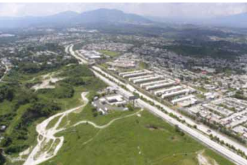
Foto 1. Infraestructura vial en Carretera de Oro. Fuente: Marielos Marín.
