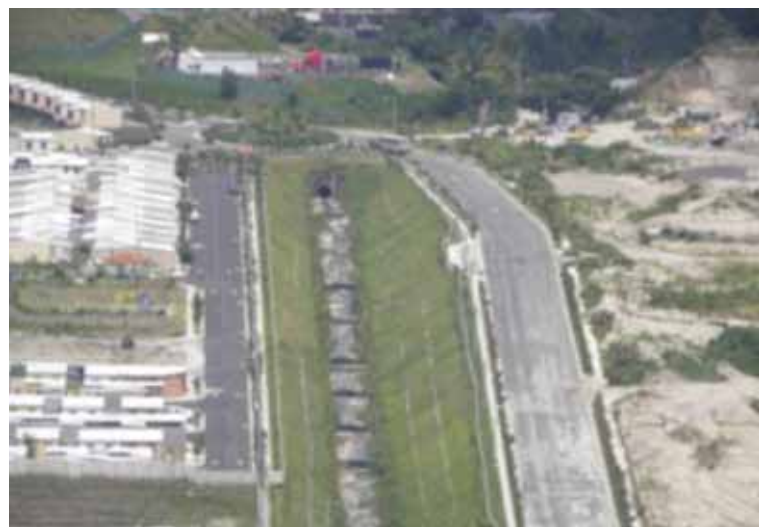
Foto 2. Drenajes de aguas lluvias. Fuente: Marielos Marín.
