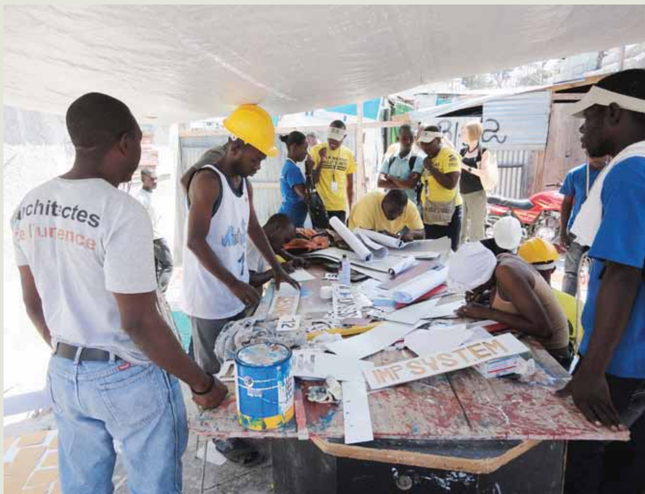
Bristout-Bobin, Haití. Proyecto de reconstrucción de ONU-Habitat en colaboración con Fondation Architectes de l'urgence. © ONU-Habitat/FAU
