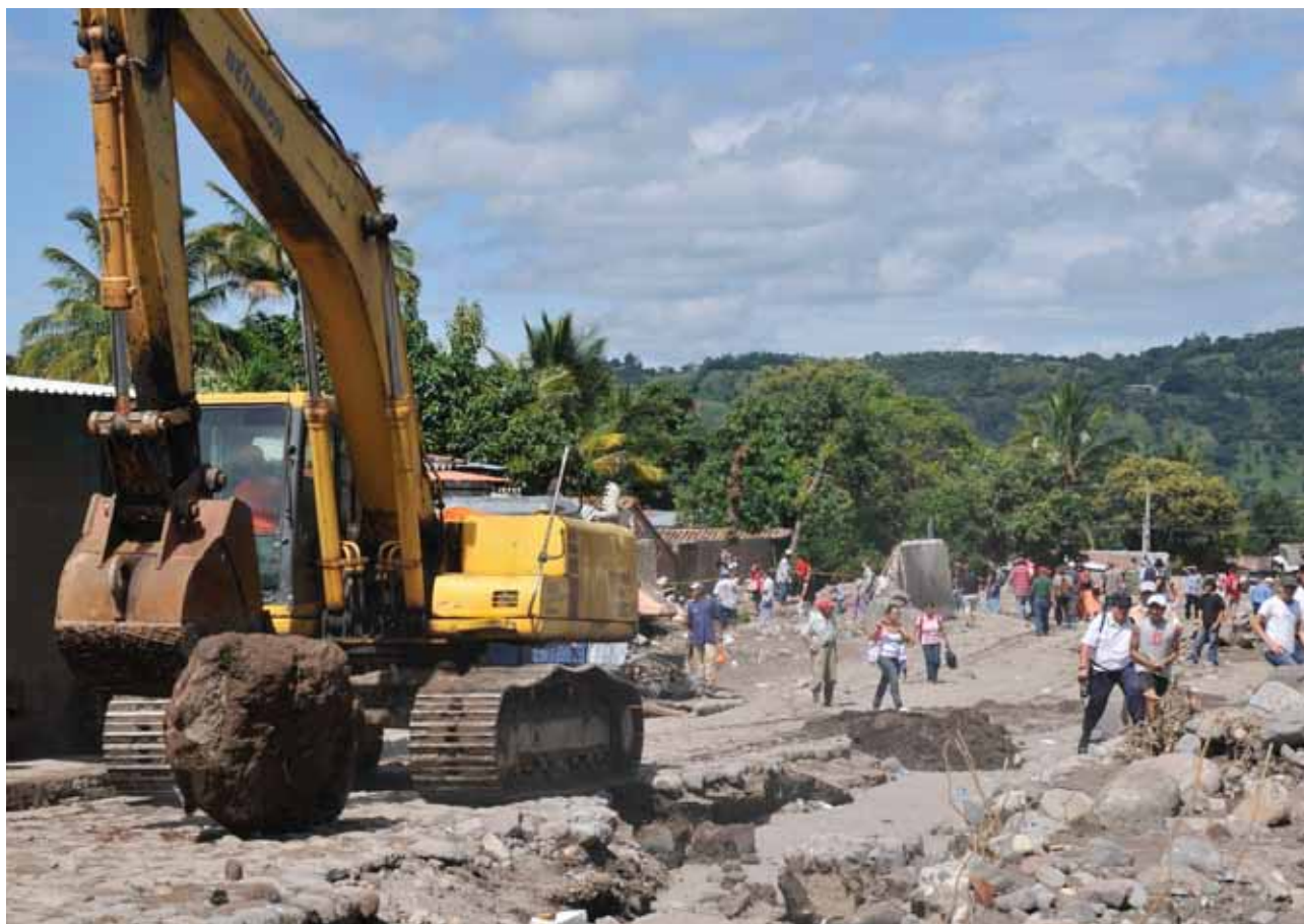
Verapaz, El Salvador. Trabajos de reconstrucción luego de la tormenta tropical "Ida" en el año 2009. © Iliana Lemus
