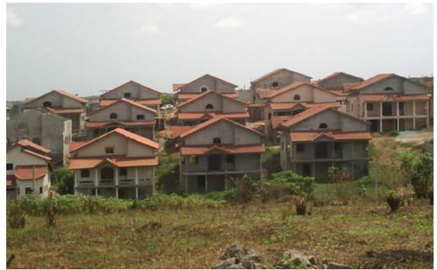
Nouveaux logements en construction (© DR).
