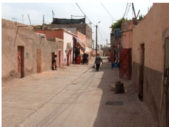
Opération de restructuration de bidonville (Marrakech, 2006)
