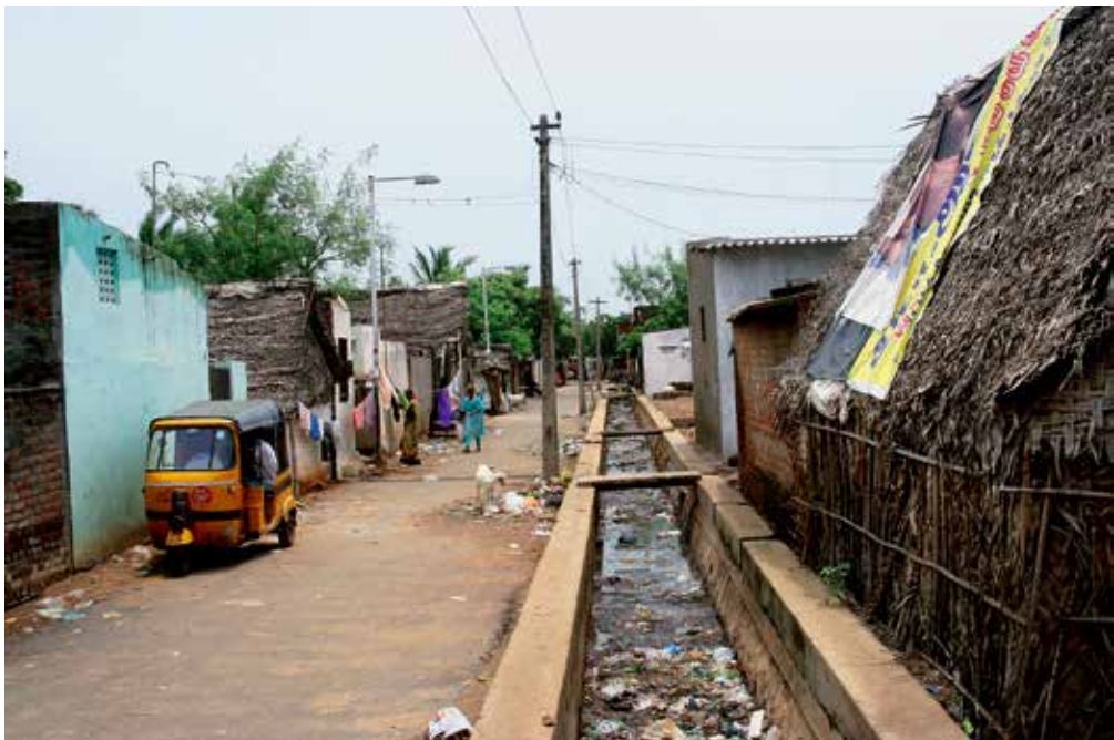
图26：在印度基础设施改善是贫民区改造项目的一部分。
