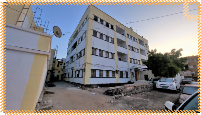
صورة لمبنى قبل وبعد الترميم ضمن مشروع «السكن الملائم» في اليمن. المصدر: موئل الأمم المتحدة.
