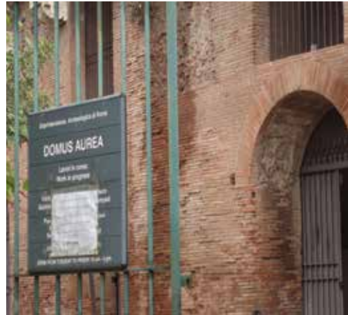
Restauración de la Domus Aurea en Roma, Italia © Flickr/Arienne McCracken
