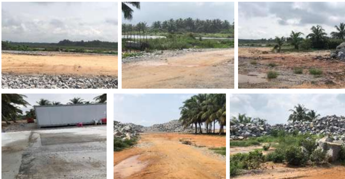
Photo 10 : Embouchure du fleuve Comoé en travaux d'ouverture
