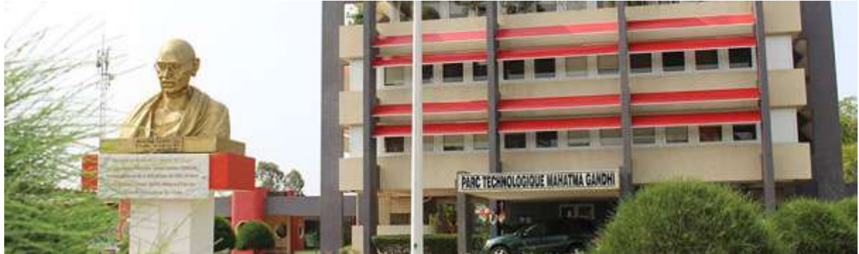
Photo 28 : VITIB dans la sous-préfecture de Grand-Bassam
