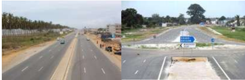
Photo 18 : Infrastructures routières à Grand-Bassam (autoroute de Grand-Bassam à Abidjan)
