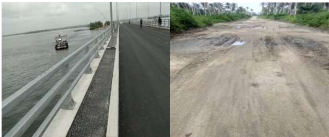
Photo 11 : Voie bitumée et Voie non bitumée
