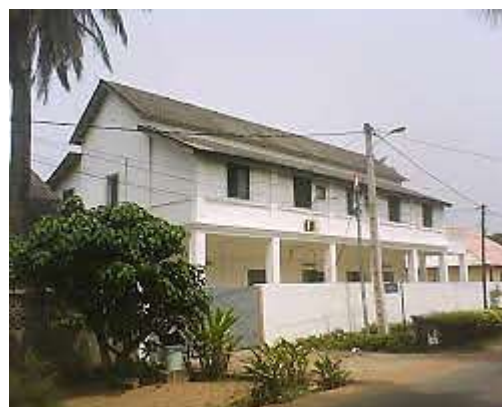
Sous-préfecture de Grand-Bassam
