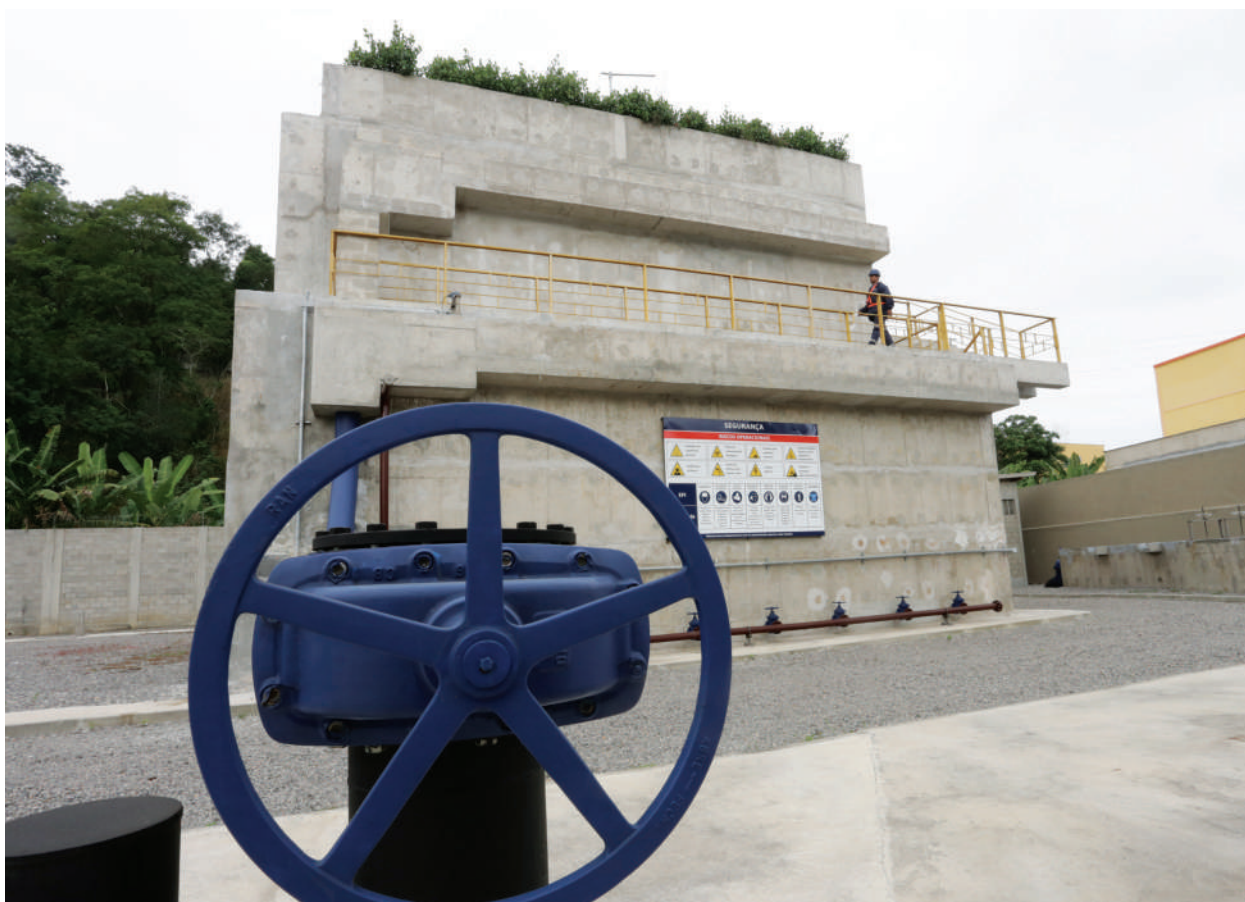
Estação de Tratamento de Esgoto (ETE) Maria Paula
