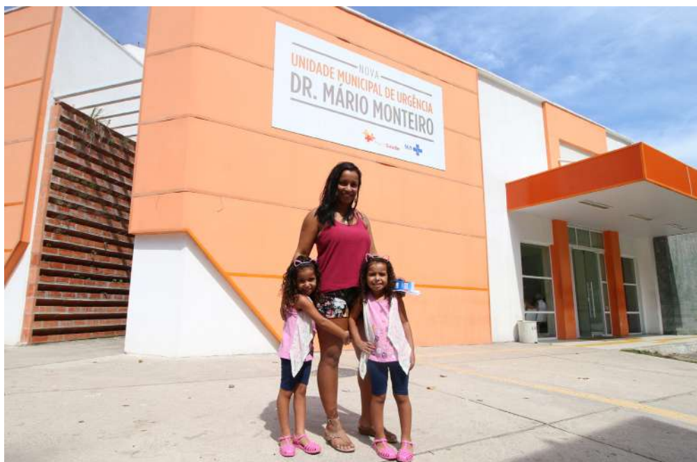
New Municipal Emergency Unit Dr. Mário Monteiro.
