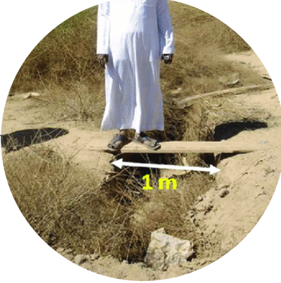
١. تشققات الأرض المرتبطة باستخراج المياه
